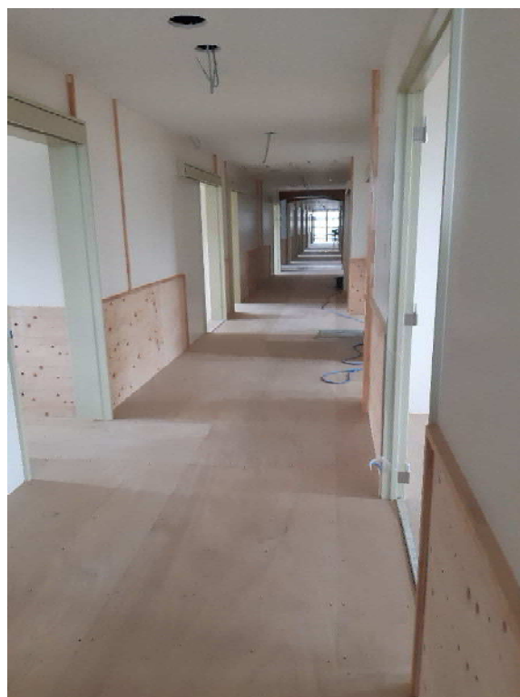
高等部棟廊下
